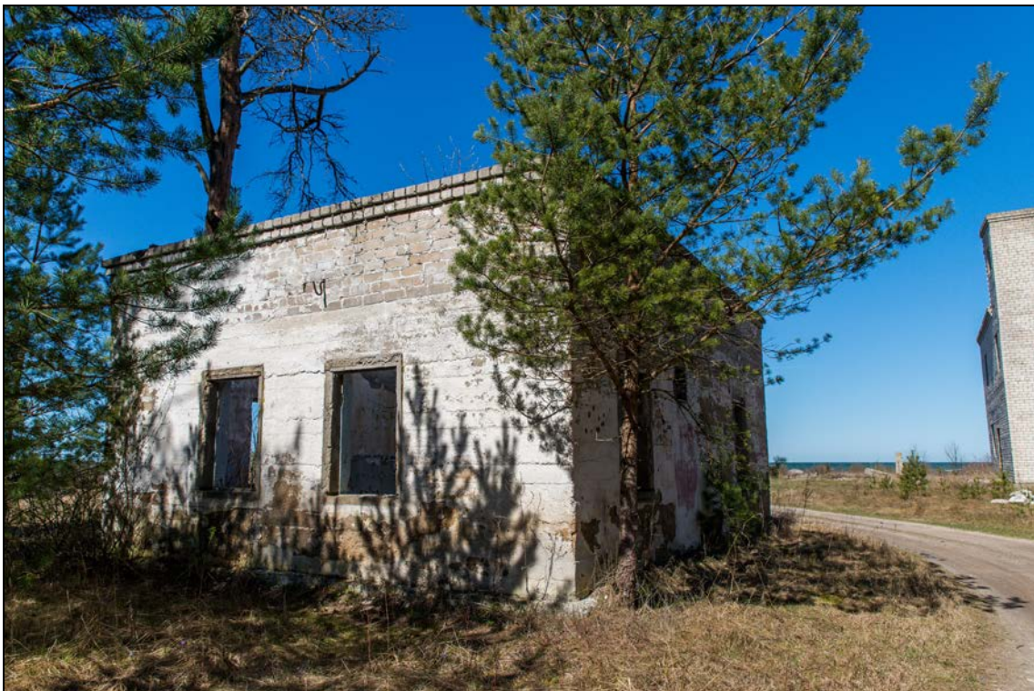
Foto 12 (195). Ramsi tehnilise vaatluse post. Hoone [2].
