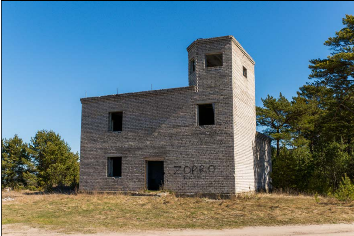
Foto 1 (189). Ramsi tehnilise vaatluse post [1]. Foto Mart Mõniste 23.04.2014.
