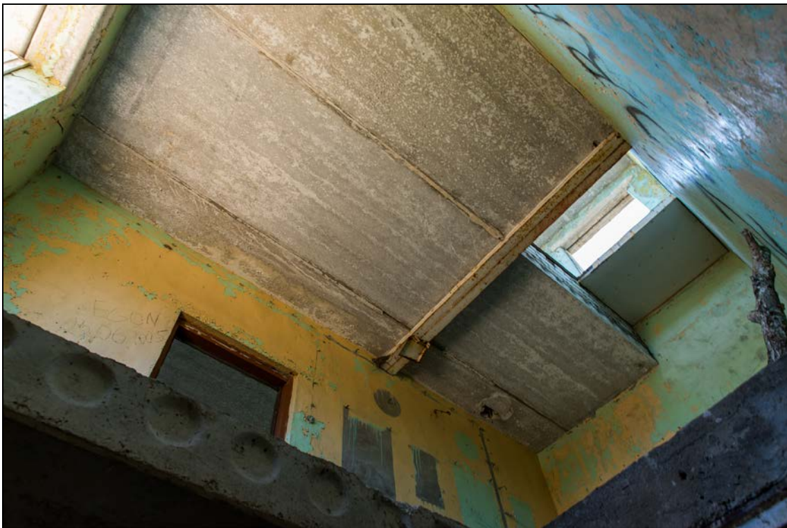
Foto 8 (218). Ramsi tehnilise vaatluse post [1], vaade trepikojast ülemistele korrustele. Konstruktsioon on heas korras, suurt läbijooksu pole näha. Foto Mart Mõniste 23.04.2014.
