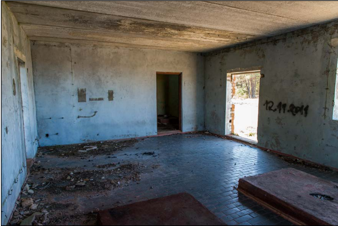
Foto 7 (212). Ramsi tehnilise vaatluse post [1], diisलगенерааторите ruum, taga trepikoja uks, metallist trepp on ära lõigatud. Foto Mart Mõniste 23.04.2014.
