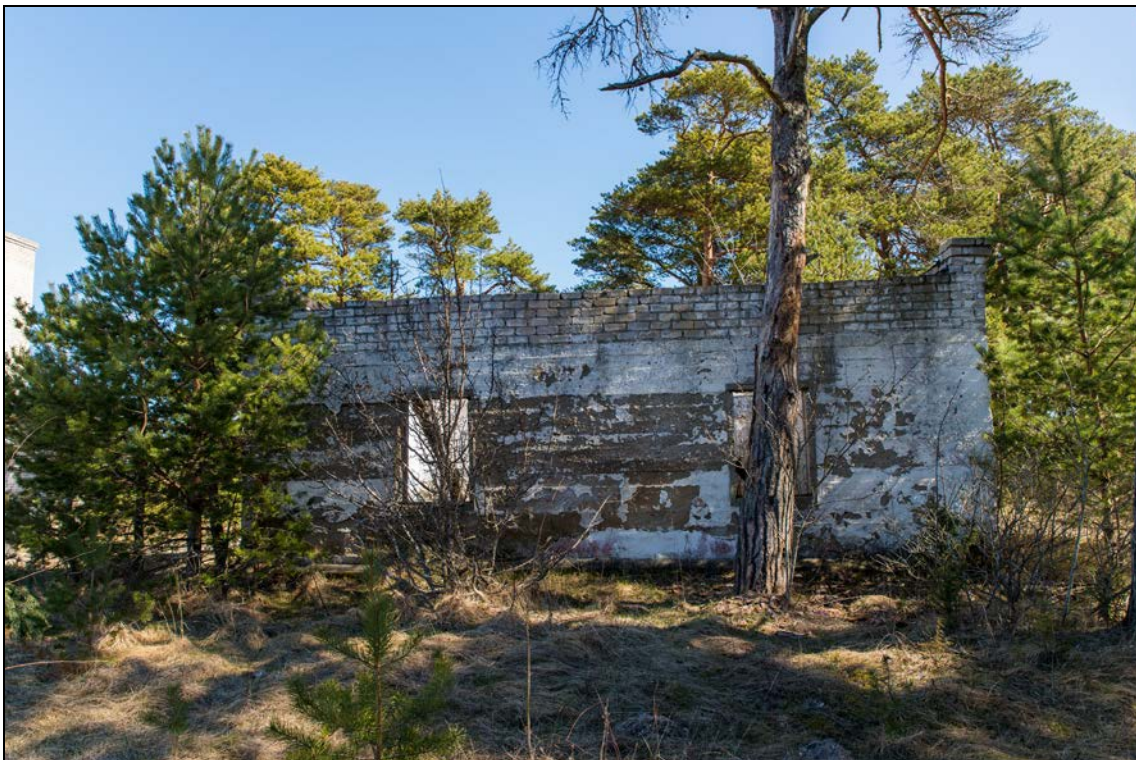
Foto 14 (192). Ramsi tehnilise vaatluse post. Hoone [2].
