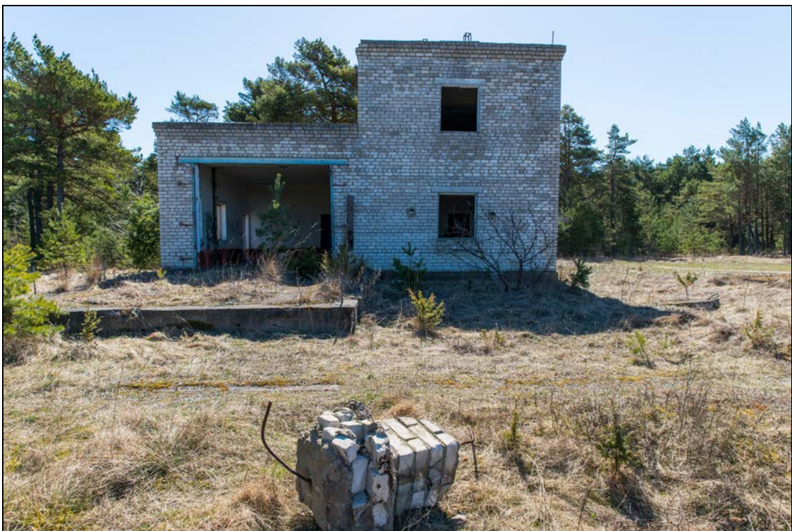
Foto 4 (206). Ramsi tehnilise vaatluse post [1], vaade põhjast. Foto Mart Mõniste 23.04.2014.
